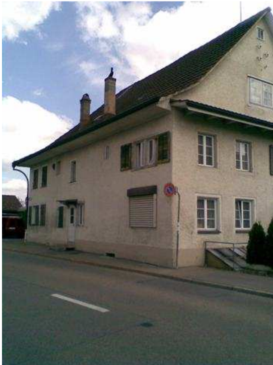
2010, linker Hausteil = Schulhausstrasse 25, rechter Hausteil = Tändelistrasse 12
