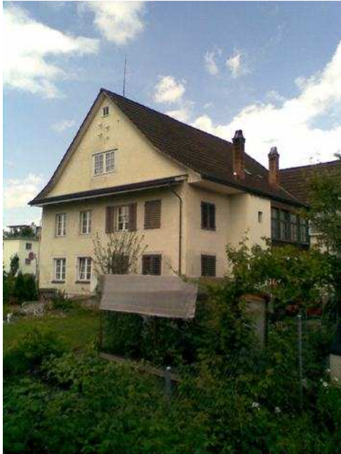
2010, linker Hausteil = Tändelistrasse 12, rechter Hausteil = Schulhausstrasse 21
