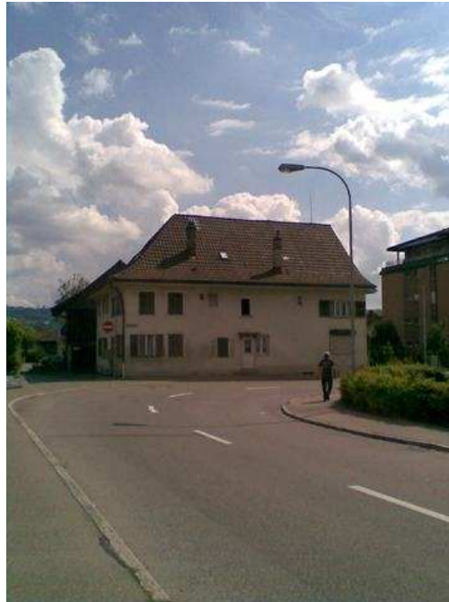
Linker Hausteil = Schulhausstrasse 25, rechter Hausteil = Tändelistrasse 12
