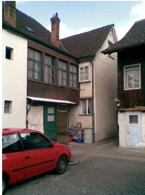
Linker Hausteil = Haus Nr. 21, Mitte = Nr. 23, rechts = Schopf (Drittel), vom Innenhof her gesehen
